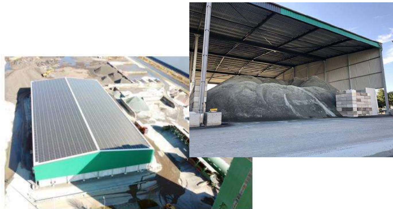
Figuur 8.6.3: Realisatie overkapping en zonnepanelen APW.
