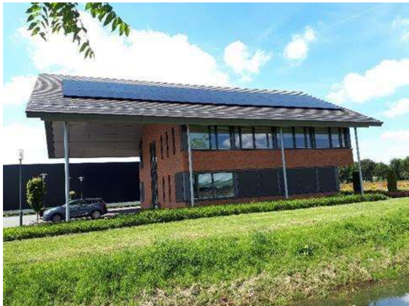
Figuur 8.2.2: Zonnepanelen op kantoor Stadskanaal.
