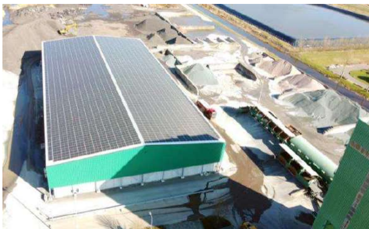
Figuur 2.2: Zonnepanelen op overkapping.
