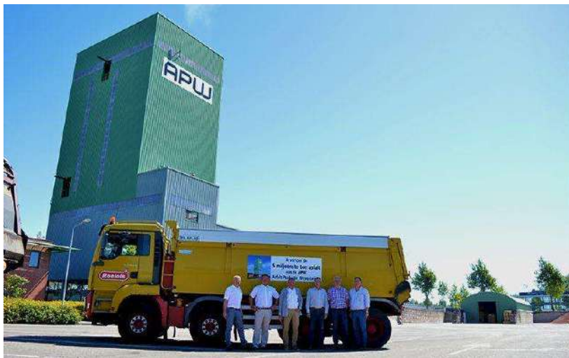
Figuur 2.1: Asfaltcentrale APW Westerbroek.
