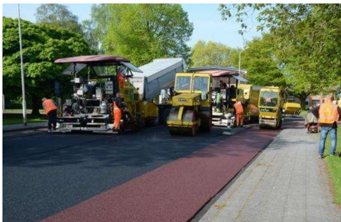
Figuur 3.1: Verwerking van asfalt (bron: Roelofs).
