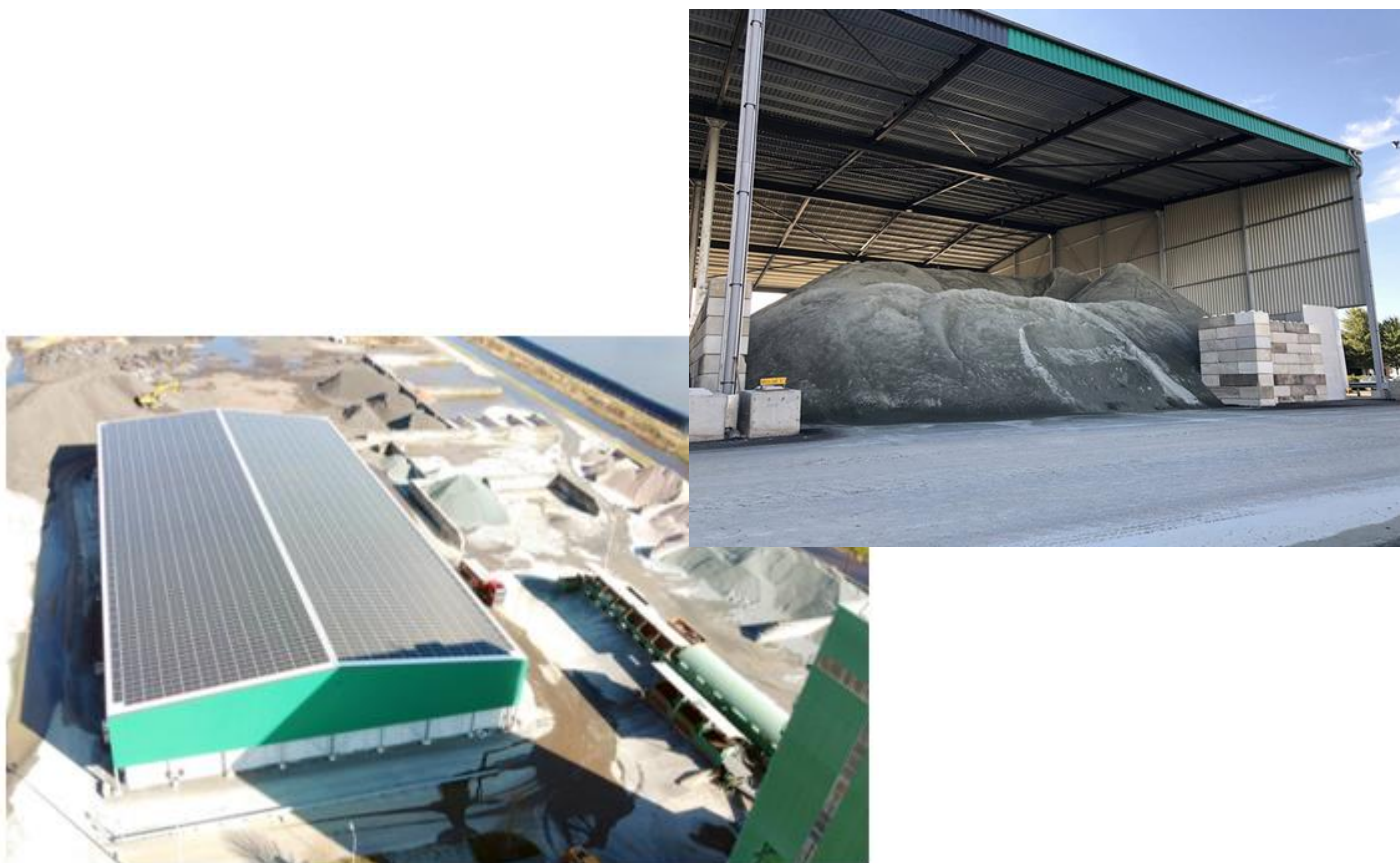
Figuur 8.6.3: Realisatie overkapping en zonnepanelen APW.
