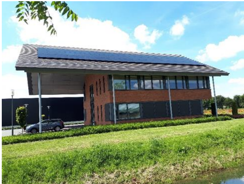
Figuur 8.2.2: Zonnepanelen op kantoor Stadskanaal.
