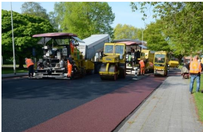
Figuur 3.1: Verwerking van asfalt (bron: Roelofs).
