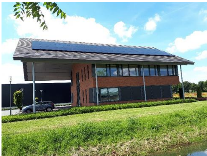
Figuur 8.3.2: Zonnepanelen op kantoor Stadskanaal.
