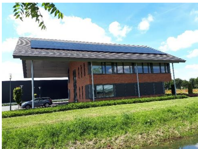
Figuur 8.3.2: Zonnepanelen op kantoor Stadskanaal.
